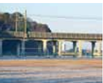
千駄堀最終処分場跡地（千駄堀スポーツ広場）
